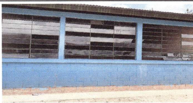
Foto 5: Sustitución de vidrio
