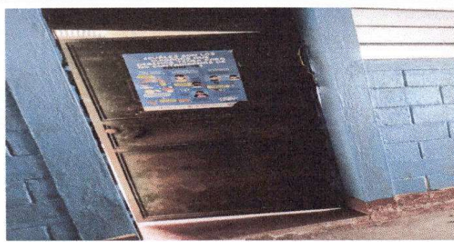
Foto 3: Mantenimiento a estructura (lijado, cambio de tubo, cepillado, sujeciones, aplicación de pintura) + Sustitución de chapa
