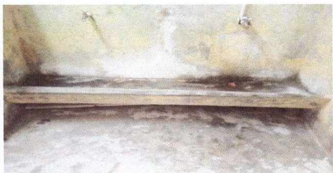
Foto 7: Sustitución de miglorios
