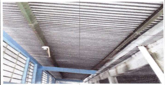
Foto 2: Mantenimiento a estructura de soporte de metal
